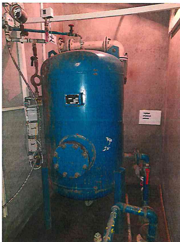
Obr.č. 1: Tlaková nádoba o objemu 500 l
